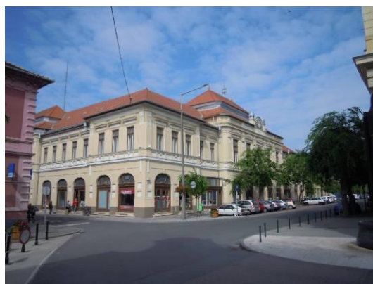
Szent István király utca 35. Városháza Megjegyzés: kívánatos lenne a díszterem fölött egykor volt torony visszaépítése
