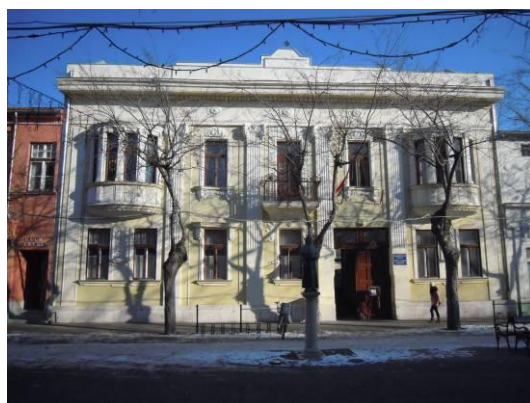
Szent István király utca 38. Művelődési Ház VOLT Tiszti klub / Kalocsai Kaszinó Megjegyzés: az épület építészeti értékeinek védelme okán az utcai homlokzaton az ablakok helyén ajtónyitás, a meglévő nyílások átalakítása és új nyílás létesítése nem engedélyezhető
