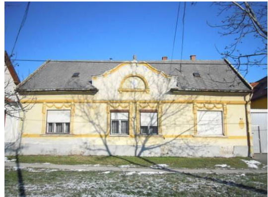
Petőfi Sándor utca 84. Lakóház (volt Stefánia Szövetség) Megjegyzés: az épület építészeti értékeinek védelme okán az utcai homlokzaton az ablakok helyén ajtónyitás, a meglévő nyílások átalakítása és új nyílás létesítése nem engedélyezhető
