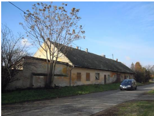
Kunszt József utca 14. Volt érseki gazdasági épületek (a nem műemlék épületek)
