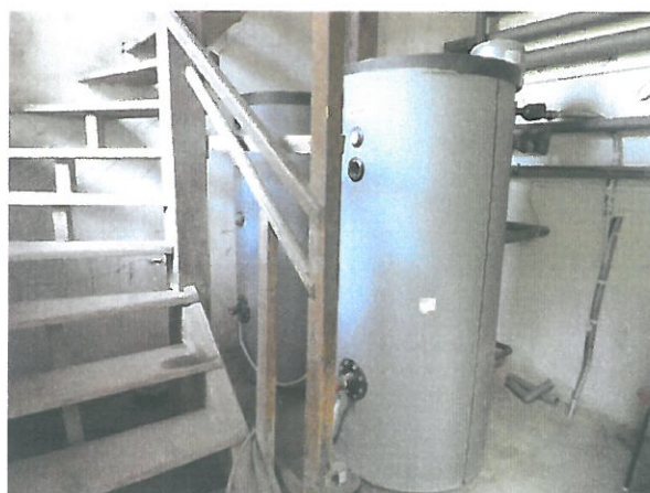
Emelet, padlásfeljáró a melegvítároló tartályokkal
